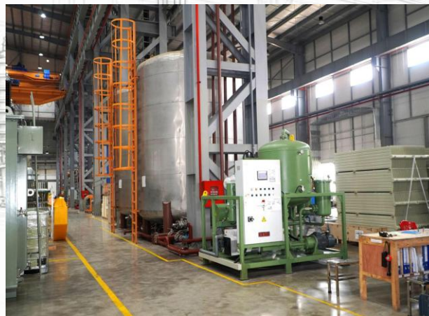
HÚT CHÂN KHÔNG & XỬ LÝ DẦU CÁCH ĐIỆN Vacuum oil filling process
