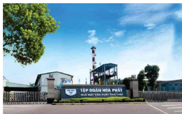
DỰ ÁN NHÀ MÁY - NHÀ XƯỞNG Factory Project
