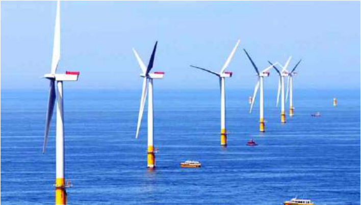
NHÀ MÁY ĐIỆN GIÓ/ Wind power plant
