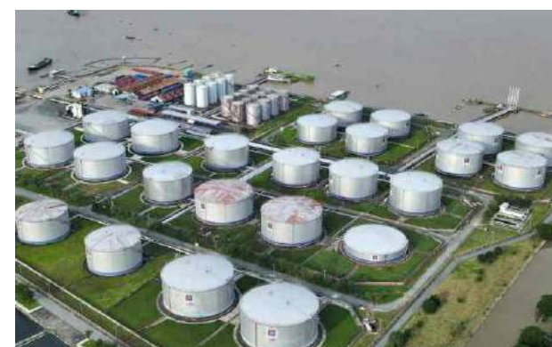
DỰ ÁN LỘC HÓA DẦU Oil Refinery Project
