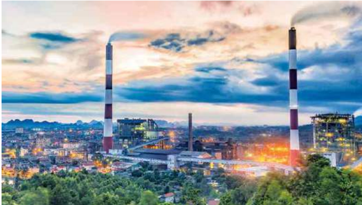
NHÀ MÁY NHIỆT ĐIỆN/Thermal power plant
